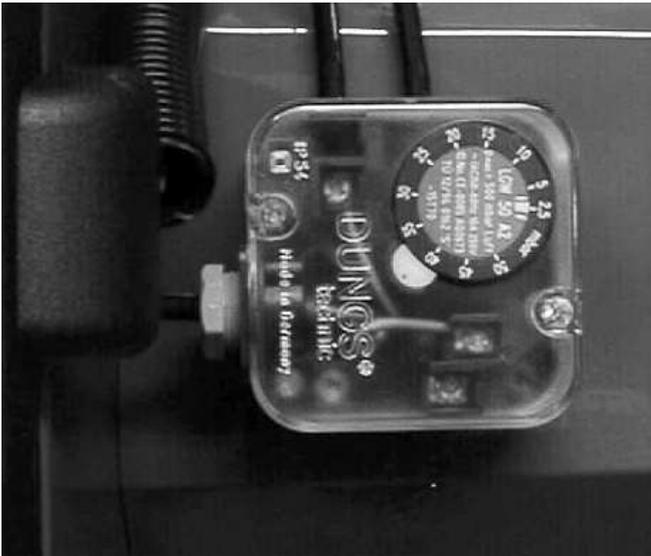
Реле контроля давления воздуха работает как дифференциальное реле давления и служит для контроля давления у горелок с наддувом.
